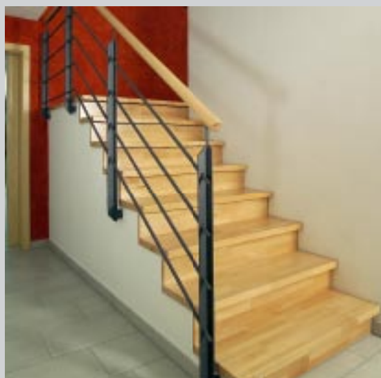
Obložení betonového schodiště
