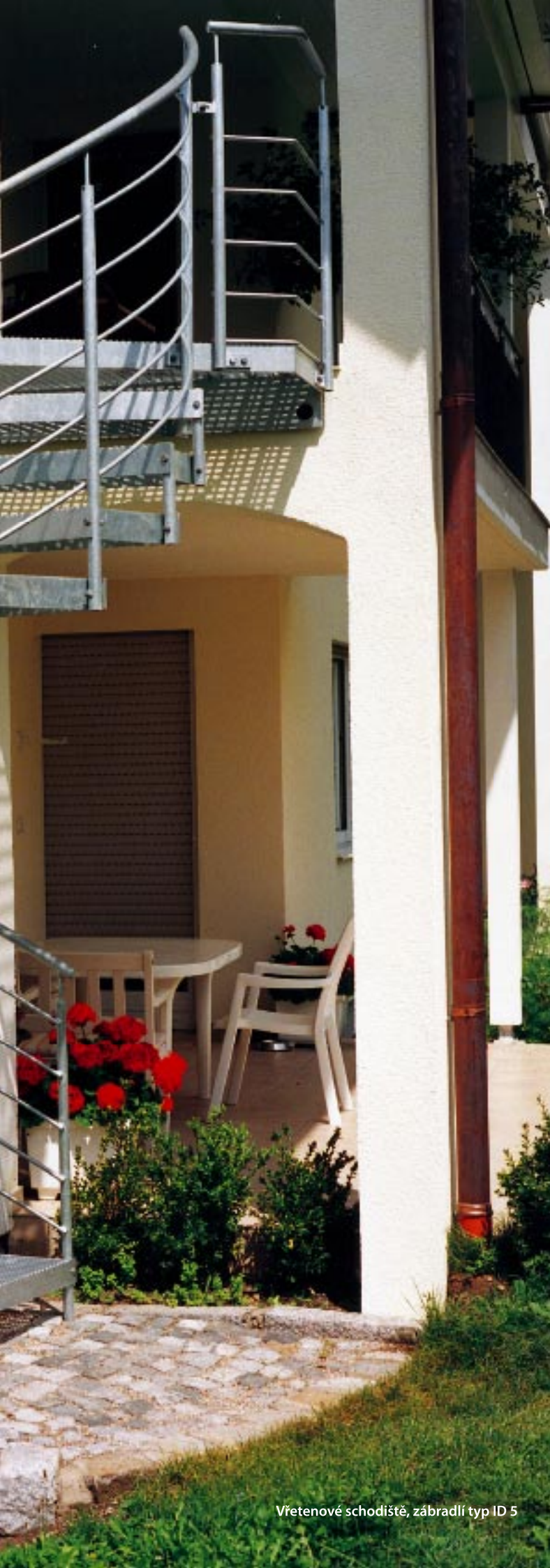
Vřetenové schodiště, zábradlí R1, pozinkováno a opatřeno základním nátěrem
